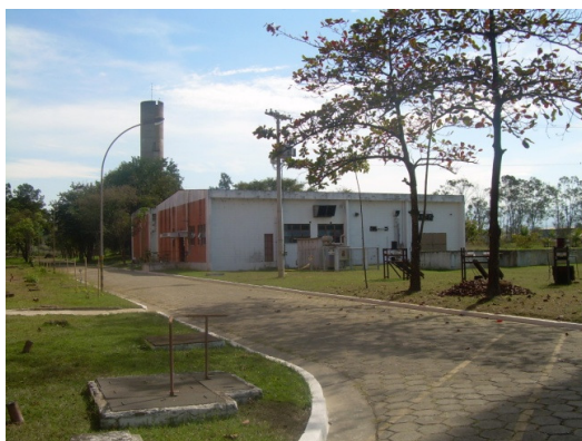
Figura 6. Vista do castelo de água do Campus Regional de Resende.
