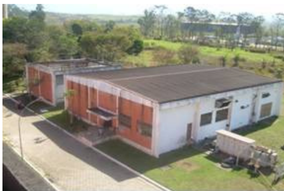
Figura 18. Vista da Casa de Máquinas onde se encontra o reservatório da água de chuva.
