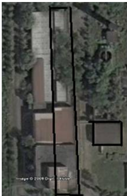
Figura 16. Vista superior do Prédio Principal e da Casa de Máquinas – área de captação.
